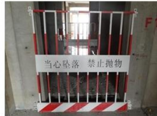
2. 电梯井防护现场实物照片
