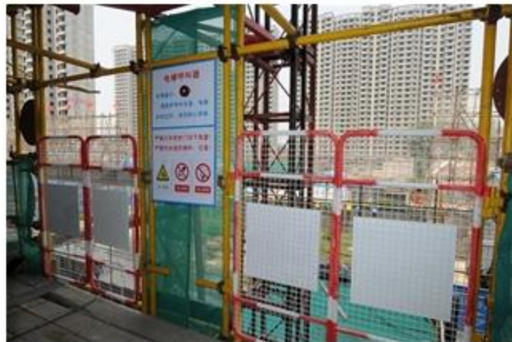
4. 施工升降机（接料平台）防护门实物图（B）
